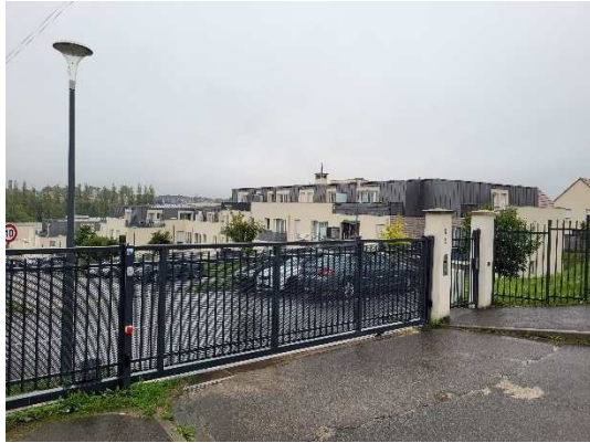
Entrée de la résidence intergénérationnelle
