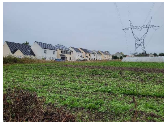
Vue sur l'opération de 12 maisons individuelles et visualisation de la ligne à très haute tension (THT)
