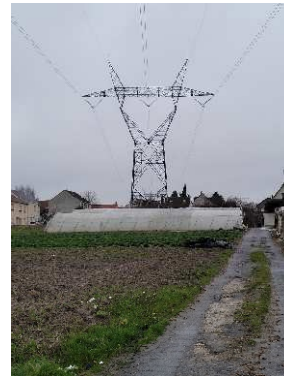
Vue du faisceau de la ligne THT, des serres et la récente zone d'urbanisation
