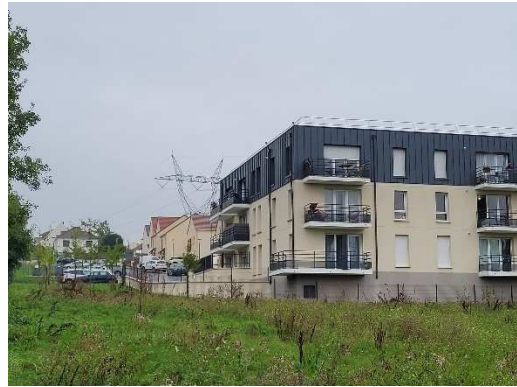
Vue de l'opération de 10 maisons et du petit collectif
