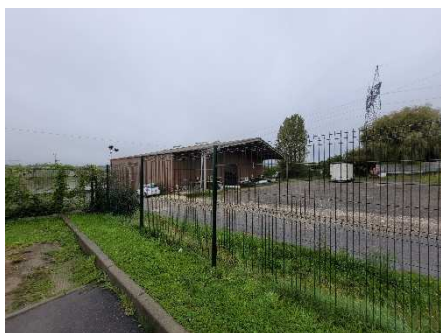
Bâtiment d'exploitation agricole et sa cour de la future Zone A
